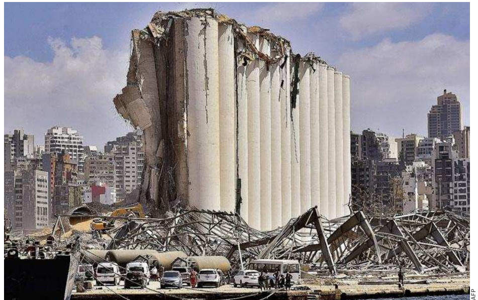
Zerstörtes Getreidesilo am Hafen: Eine Kaufmannsrepublik mit beschränkter Haftung
