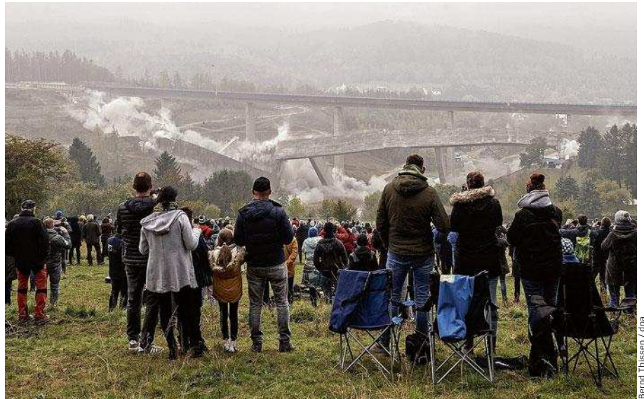
Sprengrung der Eisern-Talbrücke bei Siegen: Auf die Belastung von heute nicht ausgelegt
